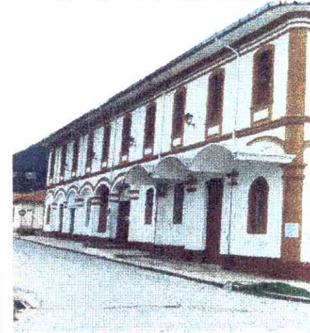
ALTERACIONES A LA EDIFICACION ORIGINAL VISIBLES DESDE EL EXTERIOR :
